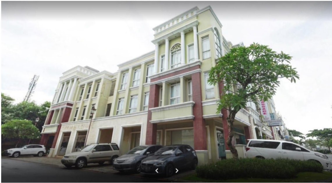
Gambar 1. Gedung Kantor Loka POM di Kabupaten Tangerang
